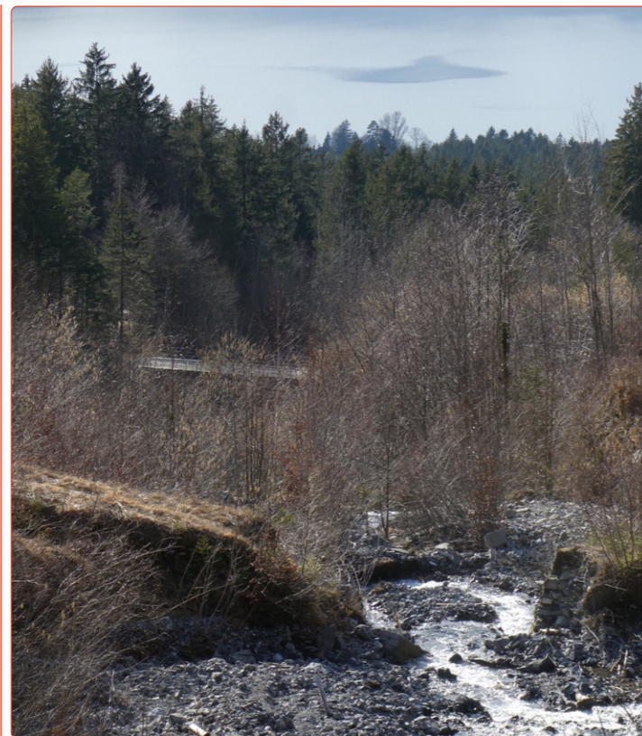
Blick von der Gummbielbrücke über den Lammbach Richtung Brienzensee: im Vordergrund die Reste der alten «Zimmermann-Brigg», im Hintergrund «Di teckt Brigg» im Februar 2024.
